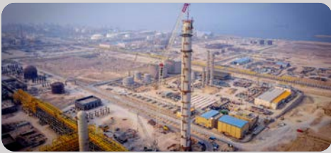
نصب آخرین قسمت از بزرگترین برج تقطیر کشور در پتروشیمی مهر پترو کیمیا
