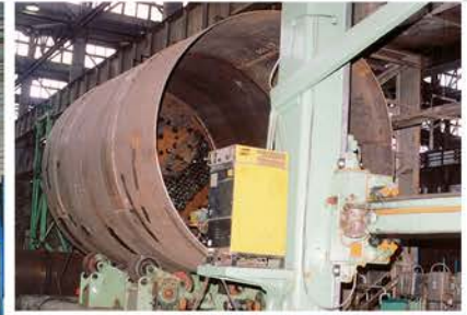
چوبندکاری اتومات بدنه دیگ Automatic welding
